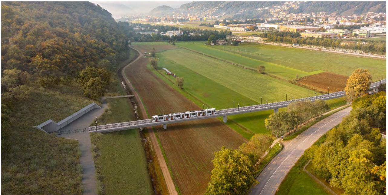
Figura 15.: Visualizzazione del portale ovest sulla piana del Vedeggio e delle prime campate del viadotto.
