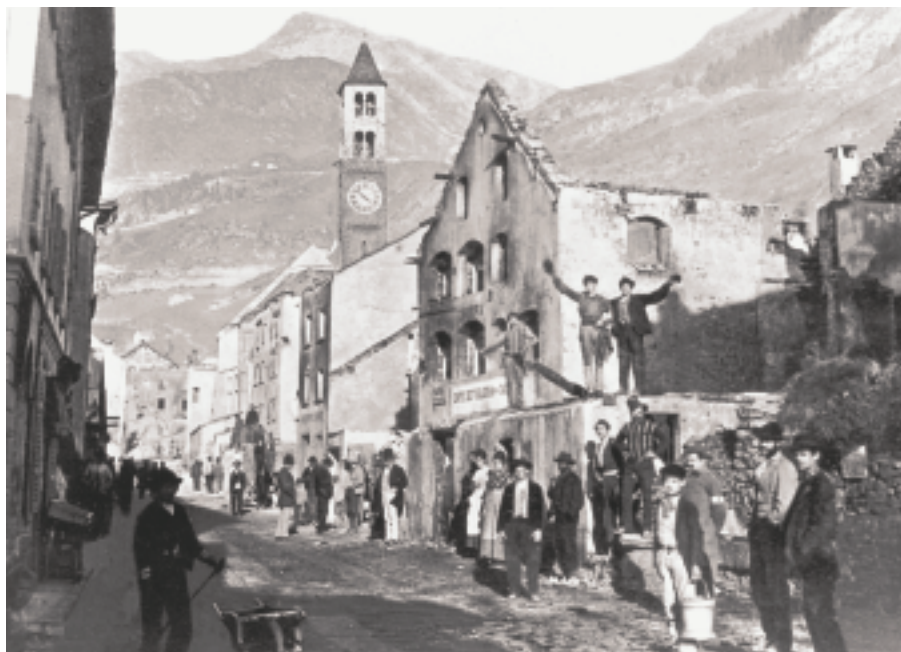
Figura 5: Dettaglio delle rovine del paese di Airolo, durante lo sgombero autunno 1877. - Caffè Bottigliera Dotta e sulla destra il sedime della casa di chi scrive. Archivio Giuliano Giulini, Airolo.
