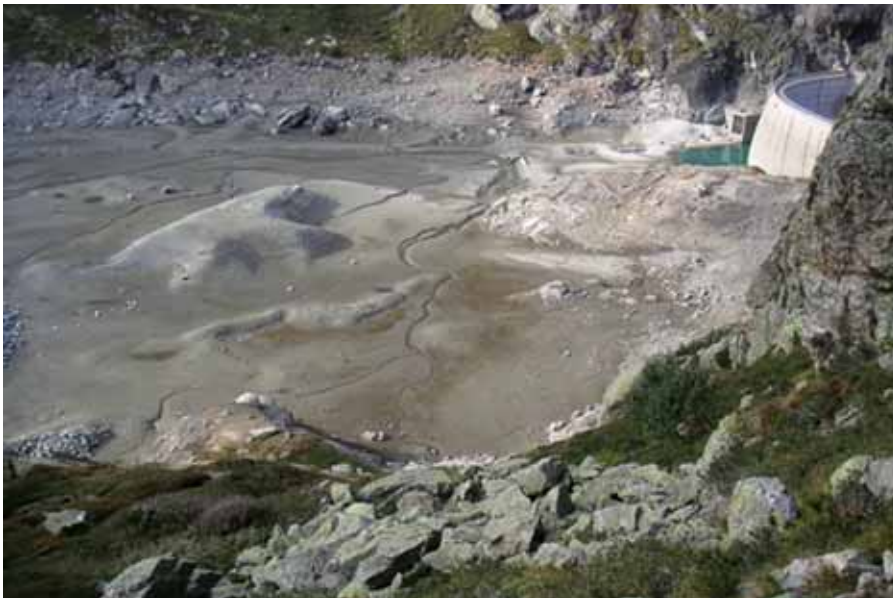
Deposito di limo e sabbia del ghiacciaio sul fondo di un lago artificialmente vuoto. Lago del Zött, settembre 2004.
