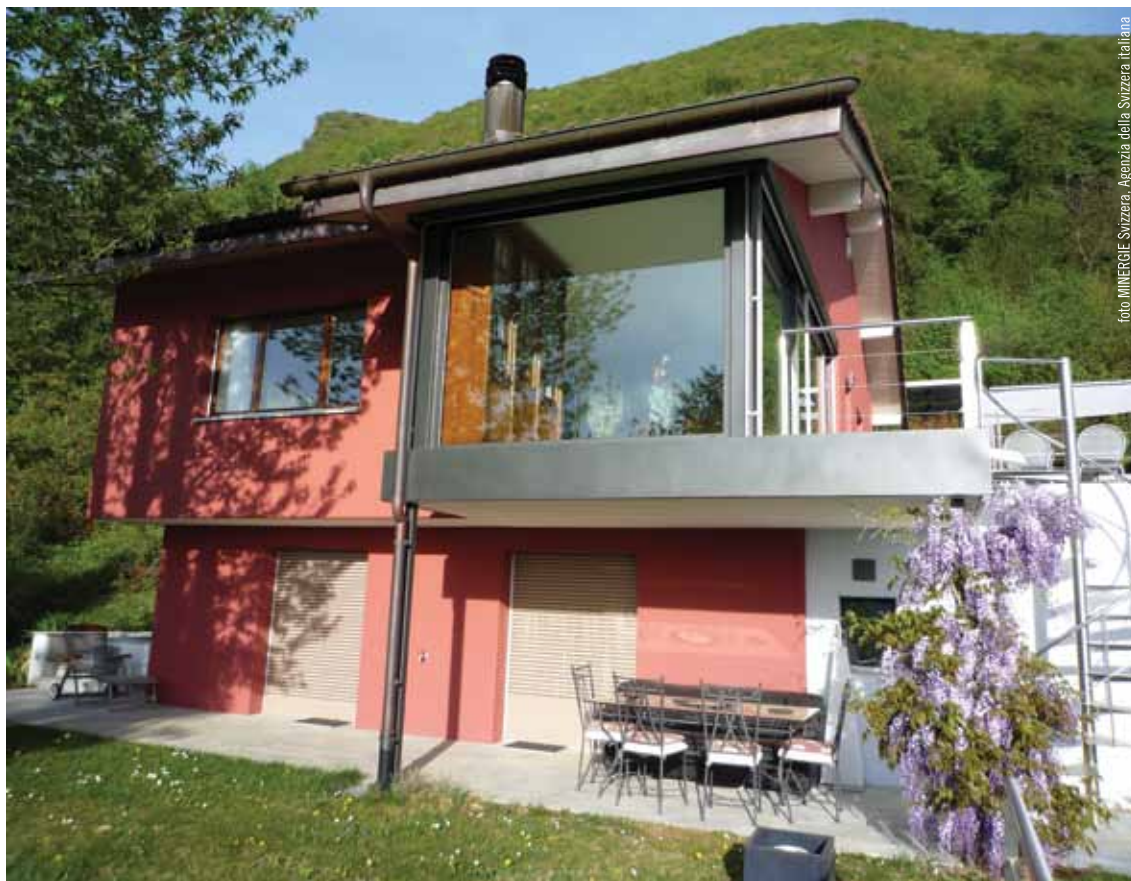
Foto: Edificio Minergie TI-217, Cureggia
