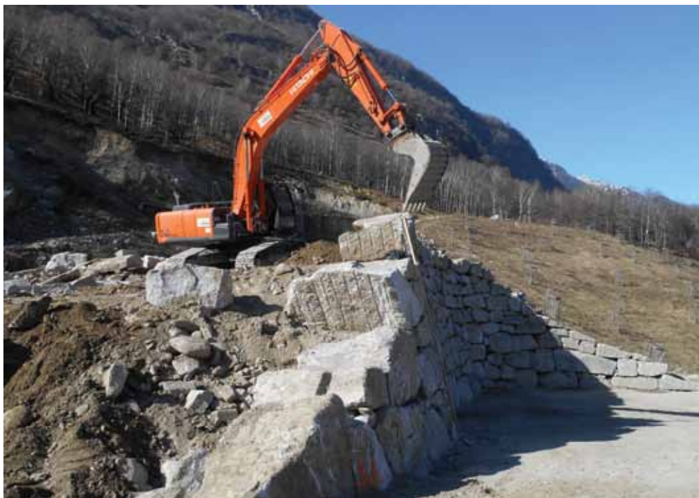
Foto: opere preparatorie della nuova tappa della discarica tipo B di Personico
