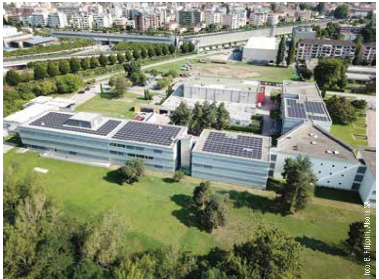
Impianto fotovoltaico sul Liceo di Locarno.
