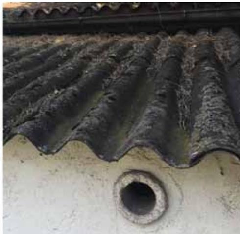
Foto: immagini di vecchie coperture ondulate del tipo "Eternit" con amianto.
