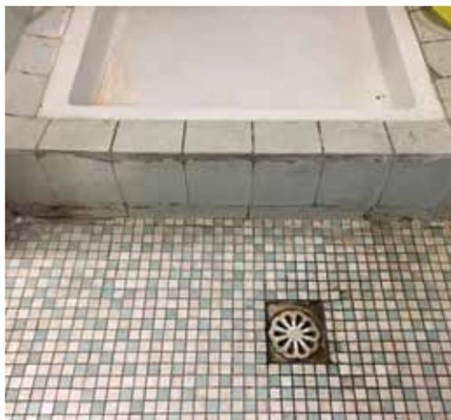
Foto: in uno stesso edificio si trovano sovente diverse tipologie di piastrelle con i relativi collanti.
