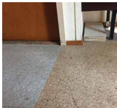
Foto: i vecchi pavimenti vinilici possono contenere amianto nella matrice sintetica (es. tipologia “Floor-Flex”, foto a in alto) o in strati sottostanti (es. tipologia “Cushion-Vinyl”, foto in basso). Oltre la metà dei pavimenti sospetti di questo tipo sono risultati esenti da amianto.
