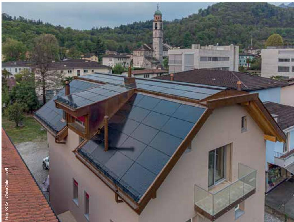
L'impianto fotovoltaico da 23,5 kW installato durante la ristrutturazione del 2020 di Villa Bianda, abitazione del 1930 ubicata a Losone. Durante il 2021 ha ricevuto il Premio solare svizzero.
