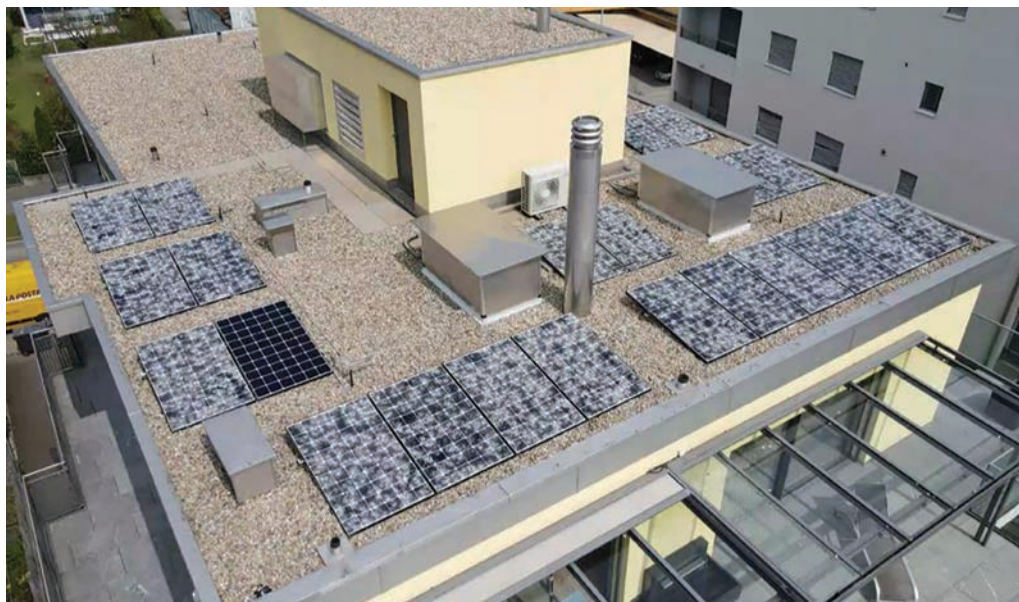
Foto: esempio di un impianto danneggiato nel locarnese durante la grandinata del 25 agosto 2023.
