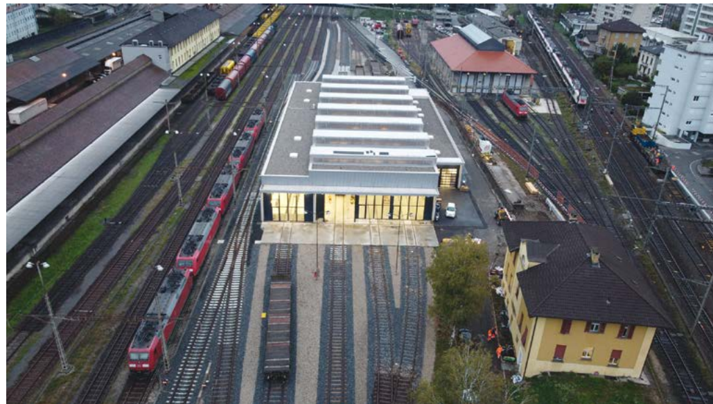
Inaugurato nel 2023, il nuovo centro di manutenzione di Chiasso (nella foto), frutto di un investimento di circa 20 milioni di franchi, ha permesso di ampliare i servizi di manutenzione di FFS Cargo a sud delle Alpi.
