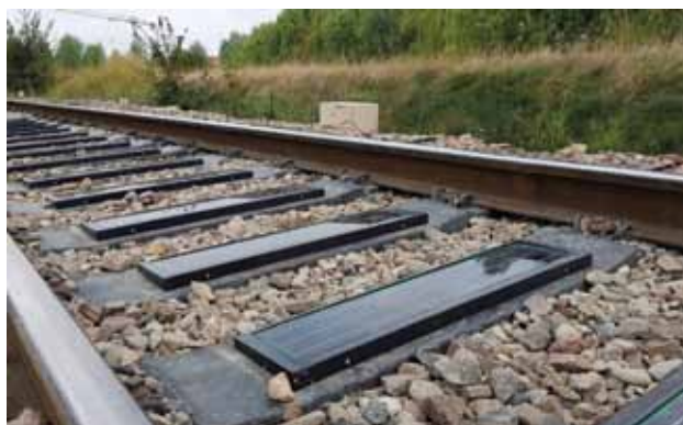
Fonte: Traverse Greenrail Solar, sviluppate da Greenrail Group Srl
